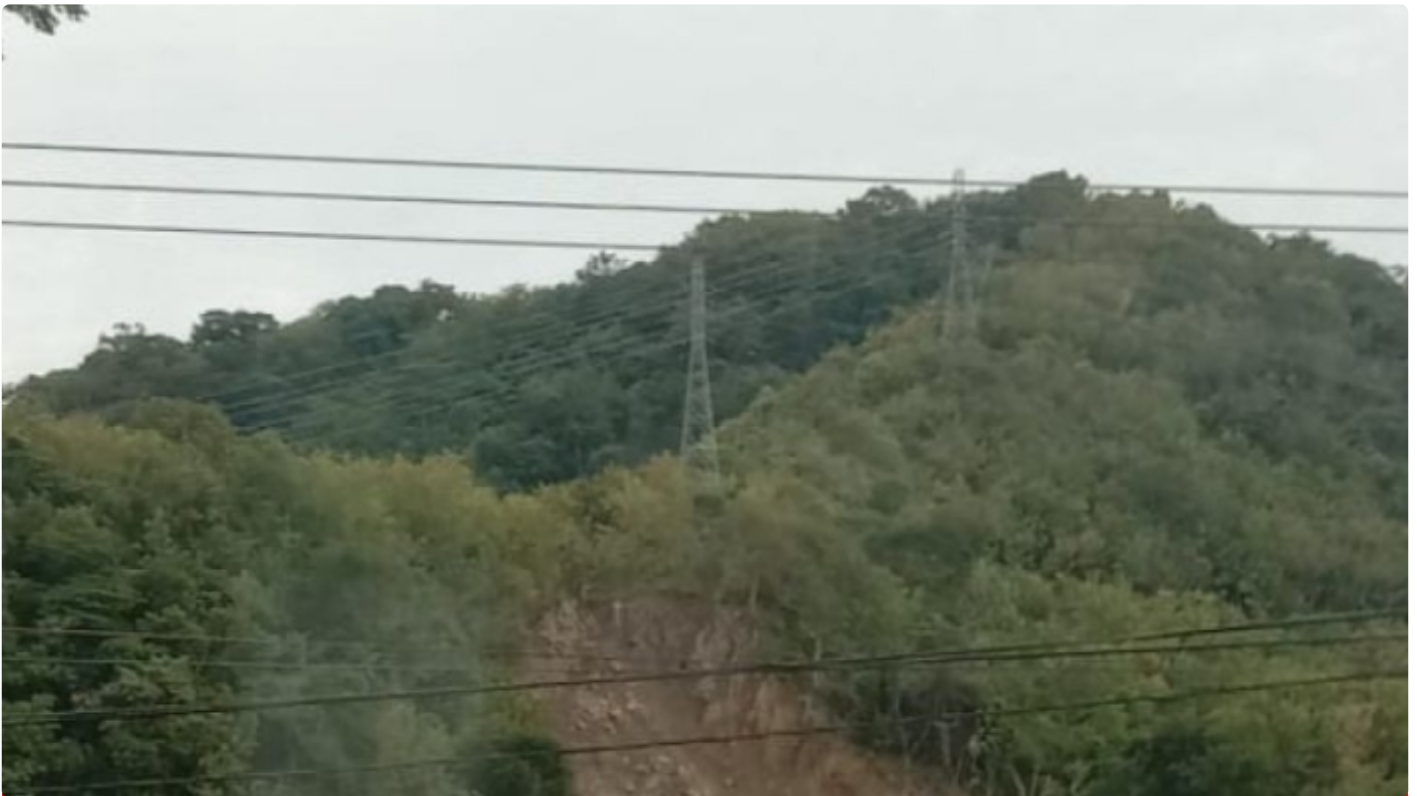
Bukit tempat berdirinya Tower Suket milik PLN mulai terkikis diduga akibat aktifitas tambang galian C
